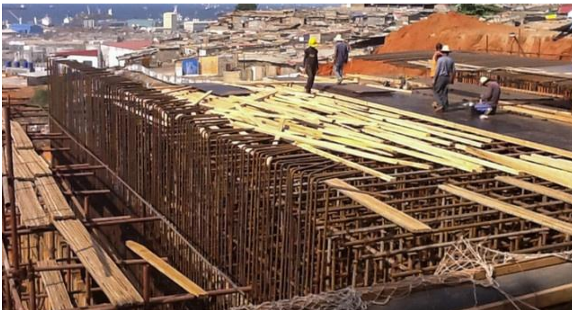
CONSTRUÇÃO DE VIADUTOS NO MUNICÍPIO DO SAMBIZANGA
