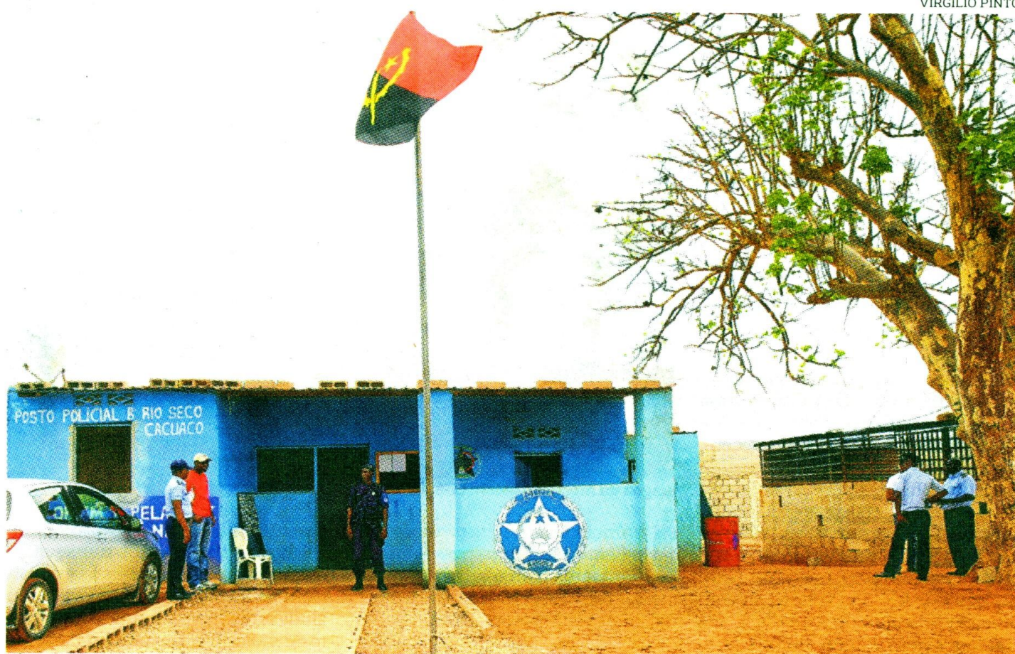
Vista frontal do posto policial do bairro Rio Seco em Cacuaço
